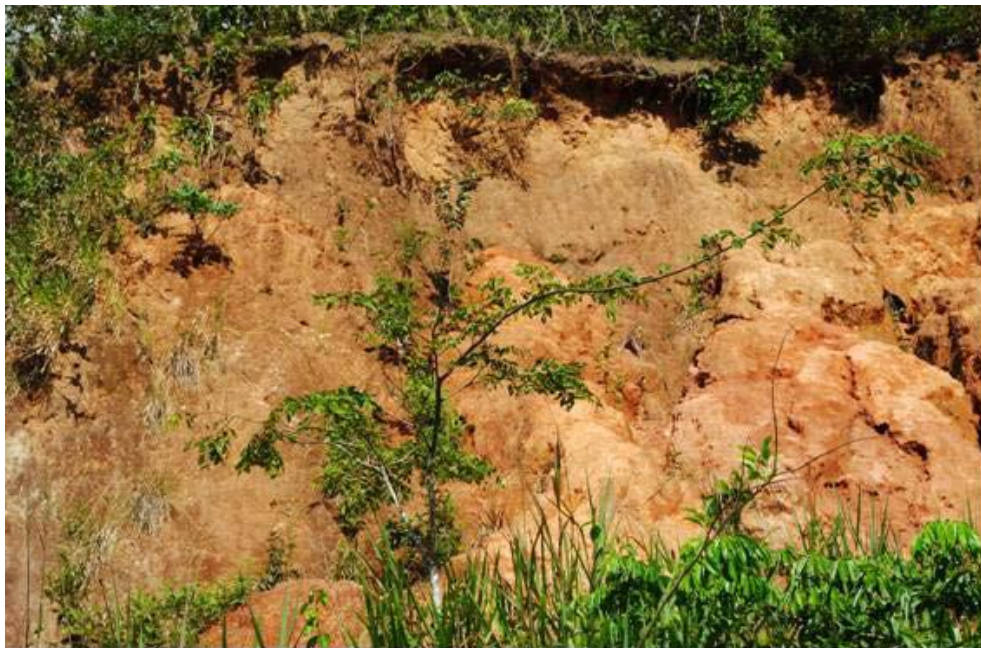
Foto 4 - Figura 5.1.28 do EIA - Exposição de Argissolo Vermelho-Amarelo latossólico em barranco erodido. Unidade de mapeamento LVAd1. Coordenadas UTM 726733 e 7511033.
