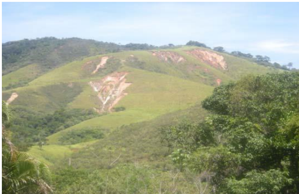
Foto 2 - Figura 5.1.22 do EIA – Morros Altos apresentando cicatrizes de erosão e movimentos de massa devido ao desmatamento.
